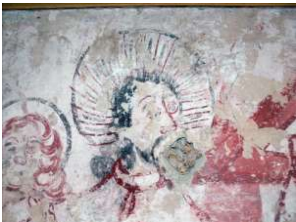
Bild 12. Dokumentation, södervägg sektion 7.4 detalj Kristus mun uttag efter tidigare infästning av träregel. Överlappande putslagning borttagen. (2-7-4.01). [U]
